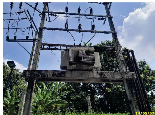
หม้อแปลงไฟฟ้าอาคาร F
